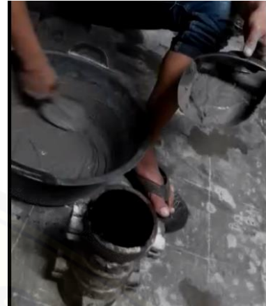
Proses penuangan beton ke cetakan
