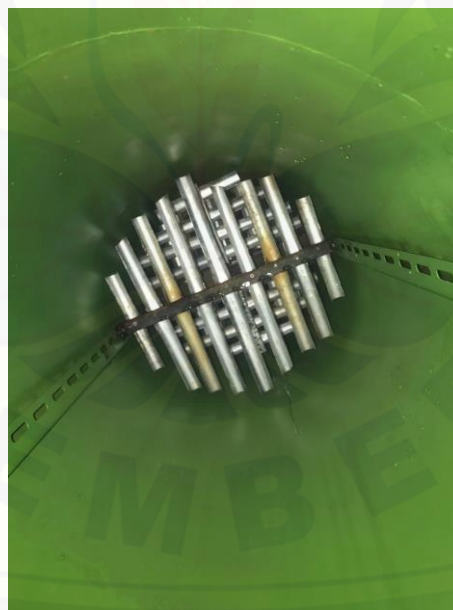
Gambar pemasangan pengisi Semicircular arc dari bawah
