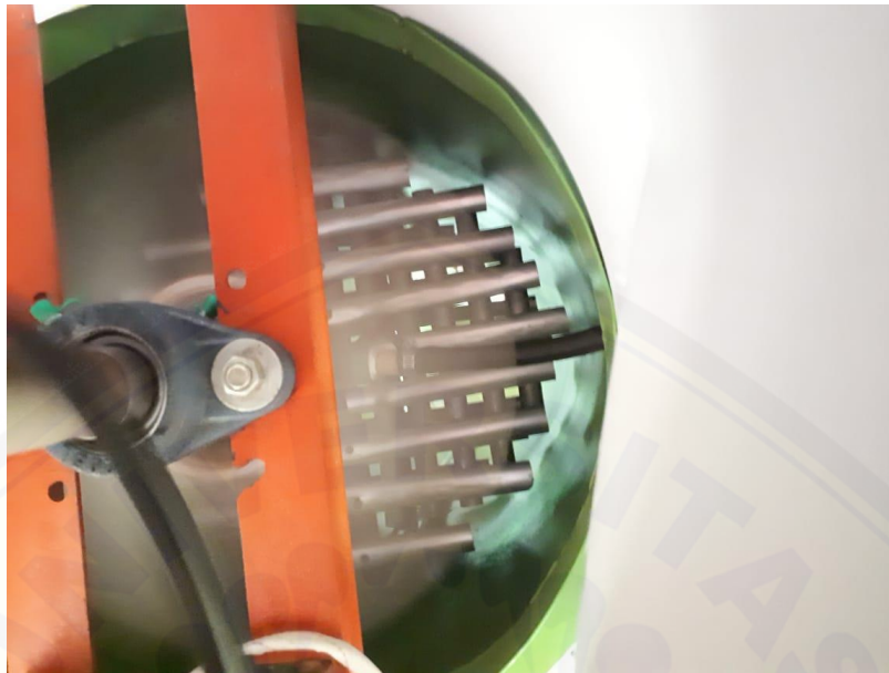
Gambar pemasangan pengisi Semicircular arc dari atas
