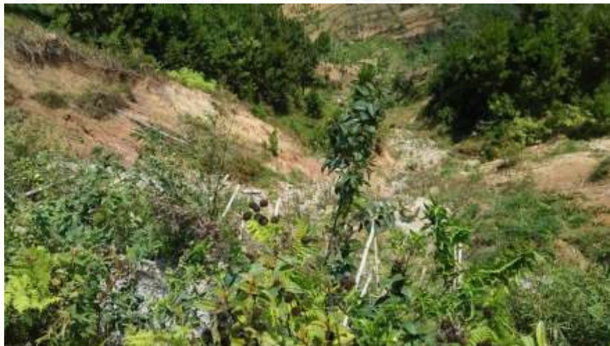
Kondisi lereng setelah longsor
