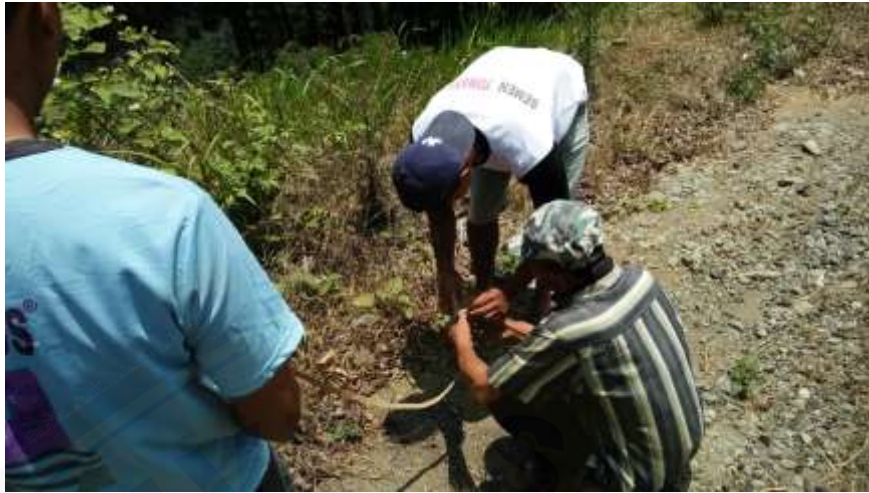
Pengukuran lebar jalan
