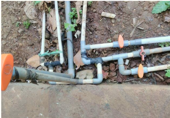
Gambar 13 Keran di tandon sumur bor untuk mengendalikan distribusi air pada konsumen
