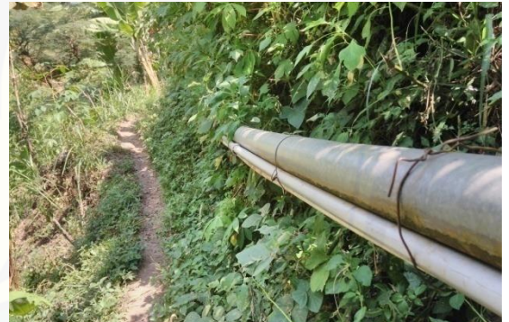
Gambar 14 Pipa air di lekatkan mengikuti alur pinggir jalan tebing
