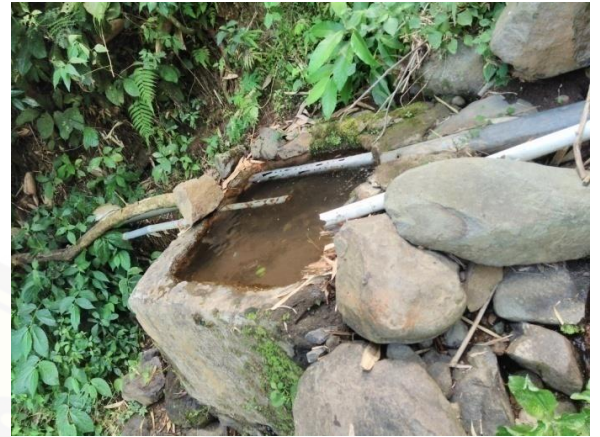
Gambar 10 Sumber Jeruk dengan 2 cabang paralon yang berbagi aliran menuju Tandon Pusat Sumber Batu Putih
