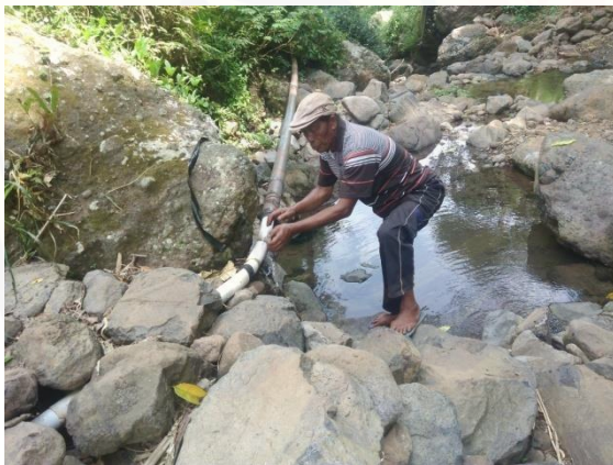
Gambar 3 Ulu-ulu sedang memperbaiki pipa pusat Sumber Batu Putih
