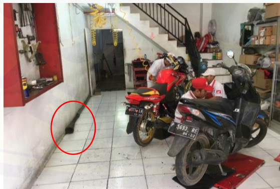
Gambar 6. Exhaust pipe tidak digunakan sebagai peredam knalpot
