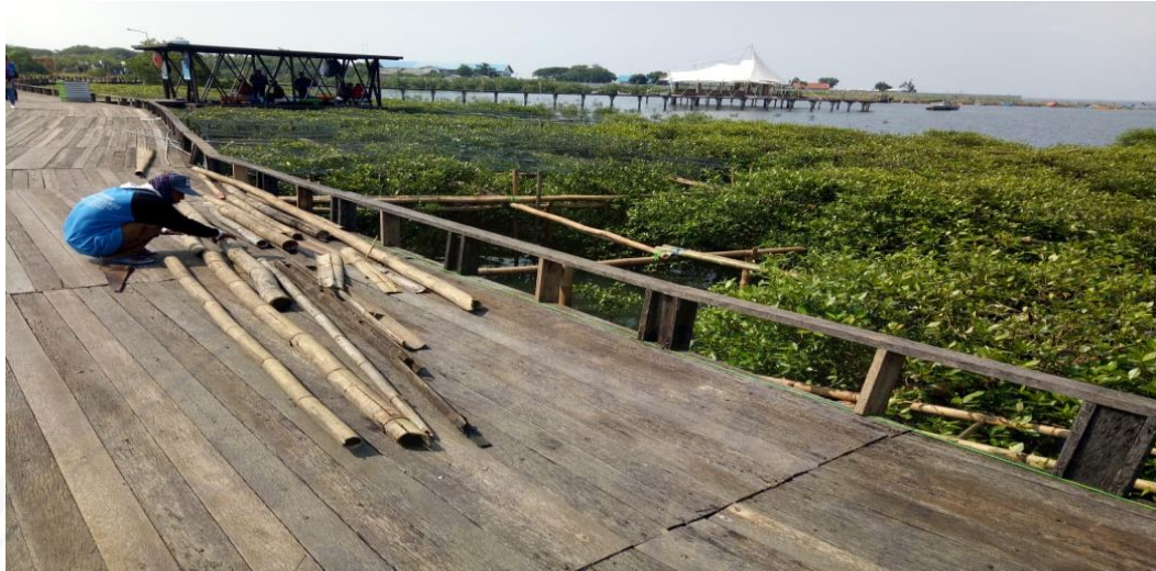
Perbaikan Jembatan Kayu Obyek Wisata BJBR
