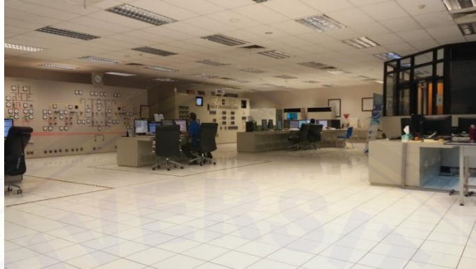
Gambar 1. Proses monitoring di CCR unit 1 dan 2 PT. PLN (Persero) Pembangkitan Tanjung Jati B
