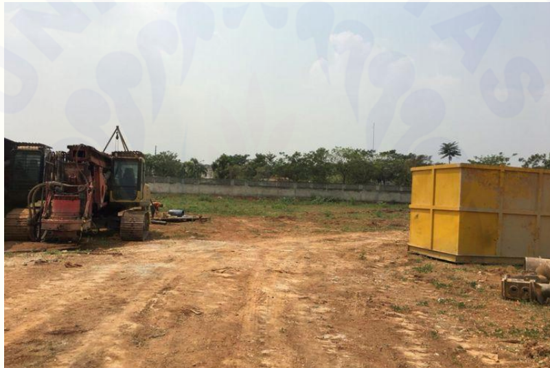
Gambar Kondisi Proyek K2 Park Serpong per 21 Agustus 2018 (Dokumentasi Ibento)
