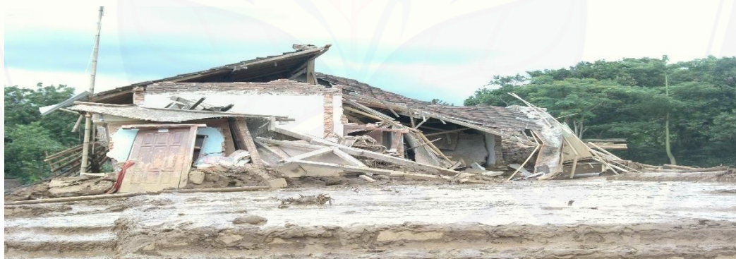
Gambar 2.15 Rumah penduduk di Dusun Gaplek yang berada di DAS Kaliputih porak-poranda di terjang banjir bandang Panti di penghujung tahun 2006. Sumber Koleksi Foto Humas Pemerintah Kabupaten Jember
