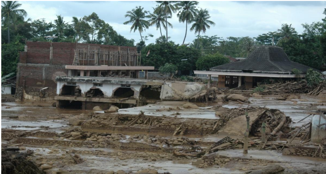
Gambar 2.12: Kondisi Pondok Pesantren Al Hasan di Dusun Bunut Desa Kemiri mengalami kerusakan berat setelah terkena banjir bandang. Sumber: Koleksi Foto Humas Pemerintah Kabupaten Jember
