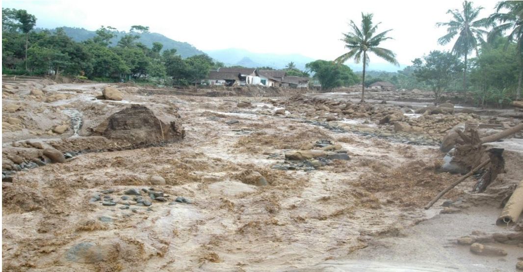
Gambar2.10 Pasar Bunut Desa Kemiri Kecamatan Panti mengalami kerusakan berat diterjang banjir bandang, rata tanah sedikit tampak pondasi bangunan pasar. Sumber: Koleksi Foto Humas Pemerintah Kabupaten Jember
