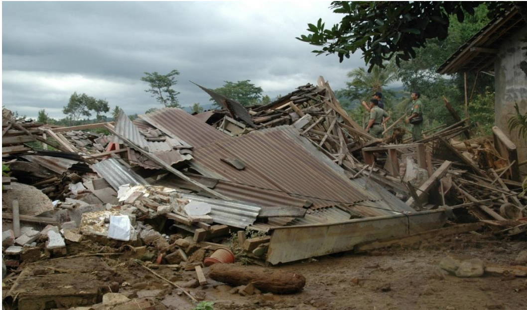
Gambar 2.8 Beberapa rumah pemukiman penduduk di sepanjang DAS Kaliputih Dusun Kantong dekat Dam Gunung Pasang, Desa Kemiri, Kecamatan Panti porak-poranda diterjang kedaksyatan banjir bandang disertai tanah longsor. Sumber Foto Humas Pemerintah Kabupaten Jember
