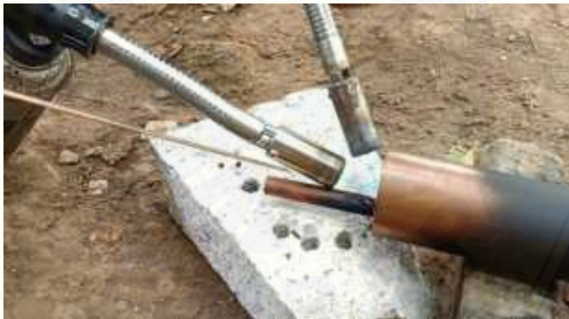
Gambar lampiran b). Pengelasan pipa air di permukaan pipa absorber
