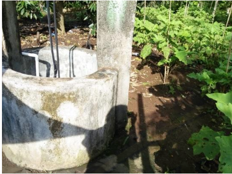
Sumur pada tanah clay loam
