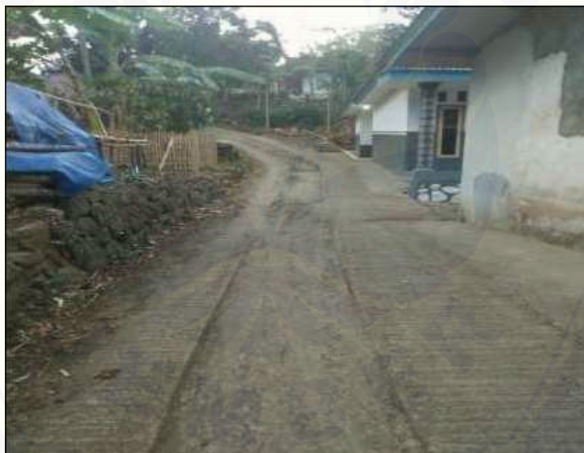
Gambar Pembangunan Jalan Rabat Beton Dusun Gluguh 2 Rt 16/ Rw 15 Desa Karangharjo
