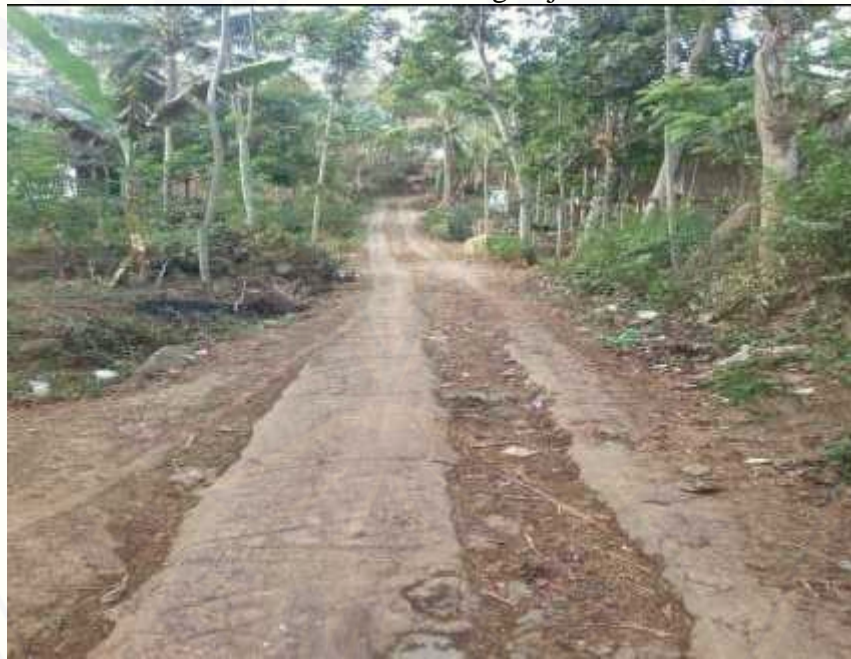
Gambar Pembangunan Jalan Rabat Beton Dusun Gluguh Rt 01/ Rw 011 Desa Karangharjo
