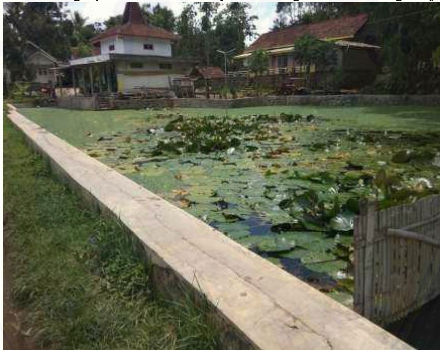
Gambar Pembangunan Embung Dusun Sumberpinang Rt 02/ Rw 30 Desa Karangharjo
