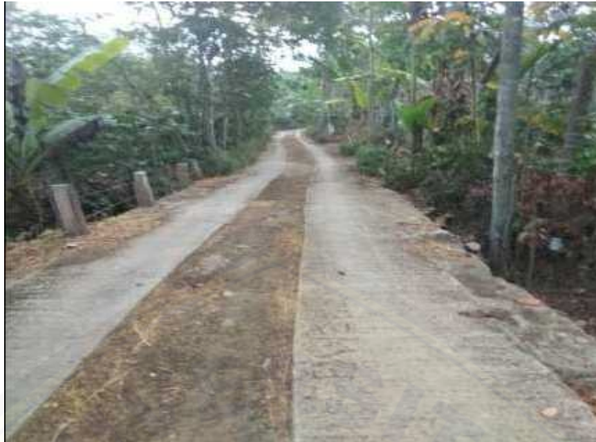
Gambar Pembangunan Jalan Rabat Beton 1 Dusun Rt 15/ Rw 14 Gluguh Desa Karangharjo
