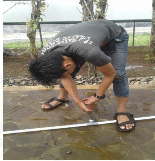
Proses Pemasangan Alat Nozzle
