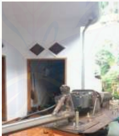
Gambar 3.6 Pembuatan besi penyangga dari sistem tail
