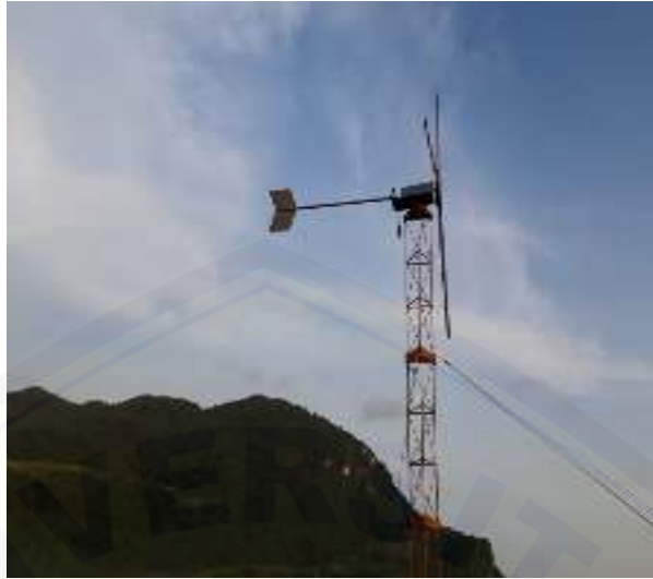
Gambar 3.14 Pemasangan sistem tail pada pembangkit listrik tenaga bayu tipe horizontal
