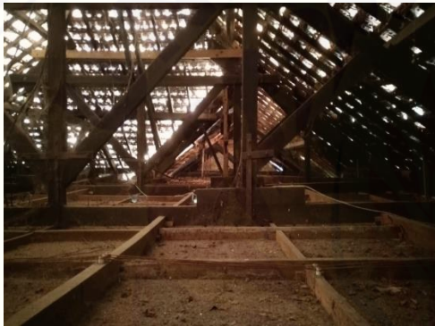
Kondisi struktur atap gedung ruang kelas
