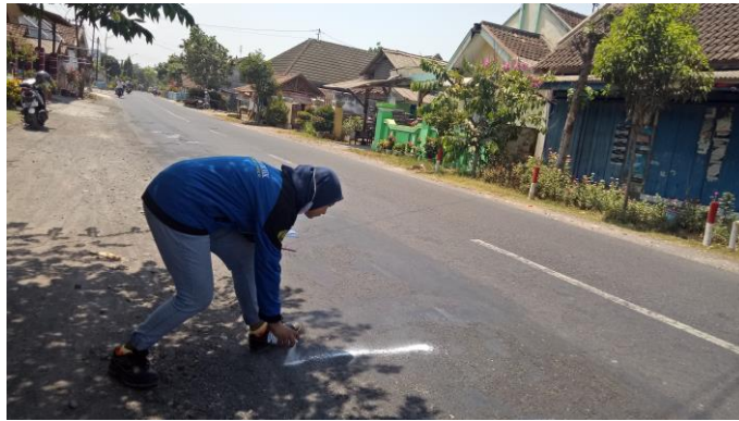
Gambar 4. Penandaan STA pada ruas Karangrejo-Yosowilangun Sumber : dokumentasi pribadi
