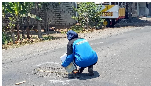
Gambar 3. Pengukuran lubang jalan Sumber ; dokumentasi pribadi
