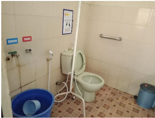
Gambar 7. Toilet Ruang Rawat Inap Kelas 3
