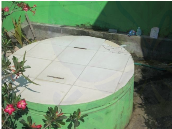
Gambar 11. Sumur Gali Tertutup
