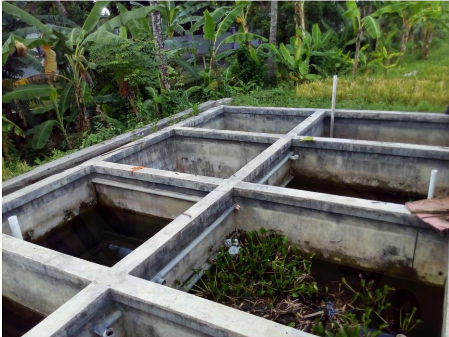
Gambar 5. Kolam filtrasi air menggunakan enceng gondok.
