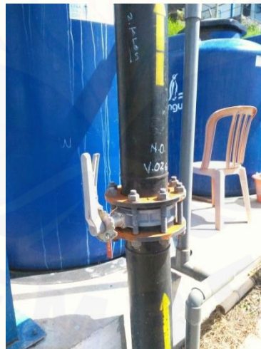
Gambar 2. 8 Katup Penutup Gas atau Pengaman Tekanan Gas
