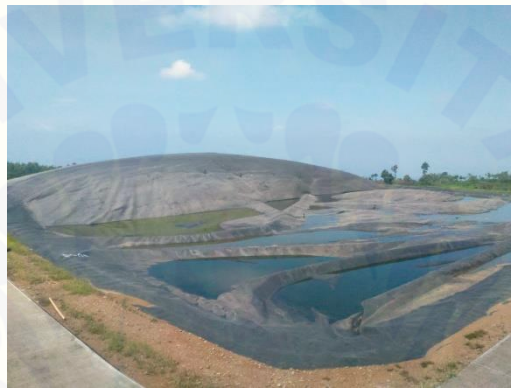
Gambar 2. 6 Digester pada PT Gunung Kawi Biogas (C.I.G.A.R)
