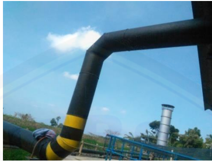
Gambar 2. 4 Saluran Masuk Slurry
