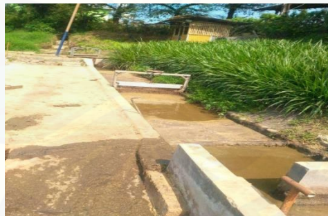
Gambar 2. 3 Bak Pemasukan ( Inlet )
