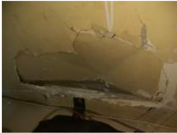
Gambar 6.5 (1) Kerusakan kalsiboard pada ruang bagian umum, (2) Kerusakan keramik pada ruang auditorium lantai 3, (3) Kerusakan plafond pada ruang sidang lantai 2
