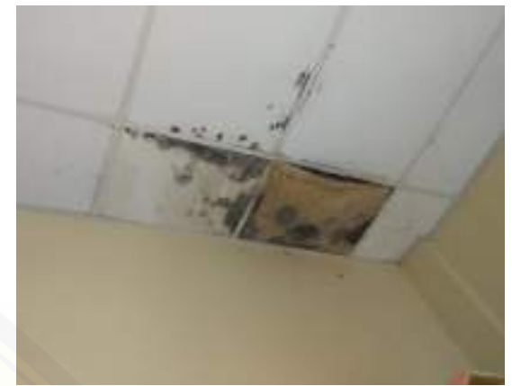
Gambar 6.5 (1) Kerusakan kalsiboard pada ruang bagian umum, (2) Kerusakan keramik pada ruang auditorium lantai 3, (3) Kerusakan plafond pada ruang sidang lantai 2
