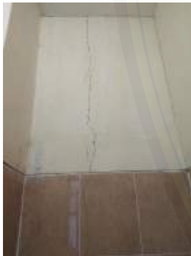
Gambar 6.6 (1) Kerusakan dinding pada toilet ruang wakil dekan 1, (2) Kerusakan kloset pada toilet lantai 3, (3) Kerusakan wastafel pada toilet lantai 3
