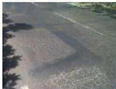
Gambar 2. 8 Retak Refleksi (Sumber: Jurnal. Identifikasi Jenis Kerusakan Jalan Pada Studi Kasus Ruas Jalan Kedungmundu-Meteseh)
