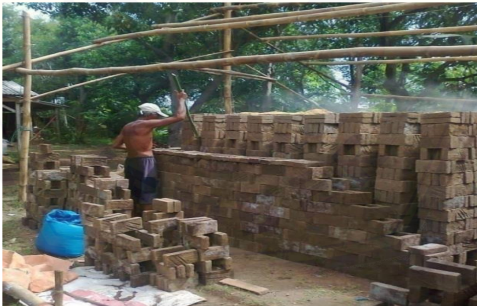
Gambar 6. Proses pembakaran batu bata
