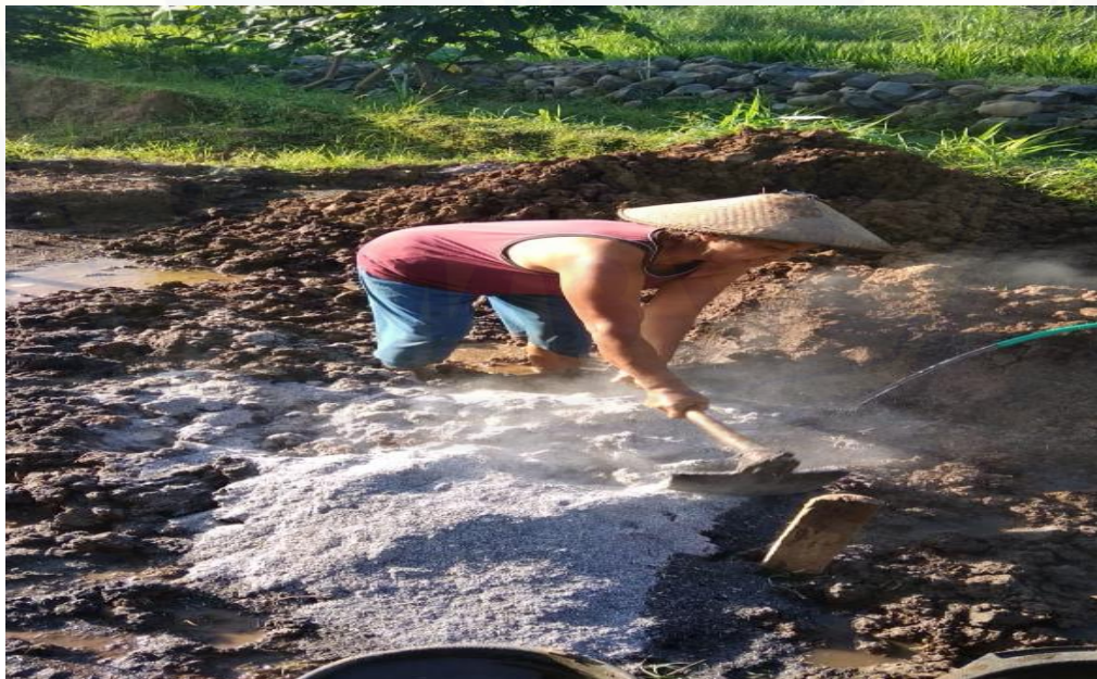
Gambar 2. Proses pengadukan tanah
