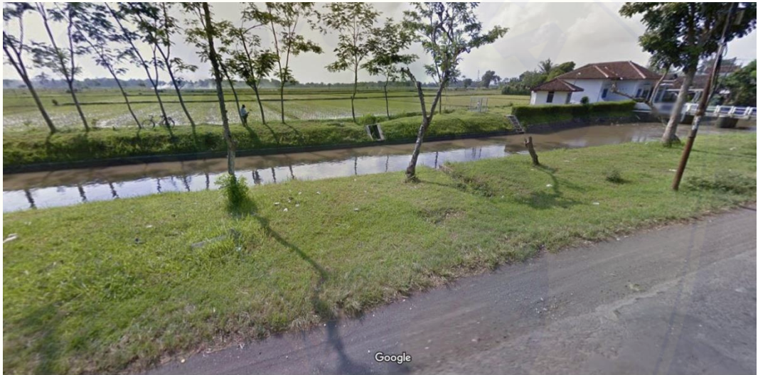
Gambar 3.1. Peta Lokasi Saluran Primer I Barat Sungai Bedadung (Sumber: Google Maps)
