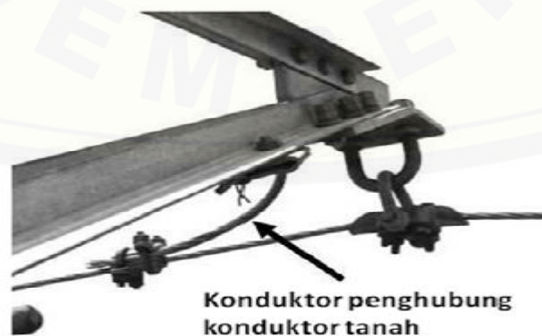
Gambar 2.11 Konduktor penghubung konduktor tanah (Buku Pedoman SUTT – SUTET PT PLN Persero)
