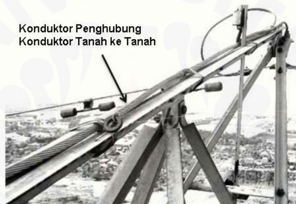
Gambar 2.12 Konduktor penghubung konduktor tanah ke tanah (Buku Pedoman SUTT – SUTET PT PLN Persero)
