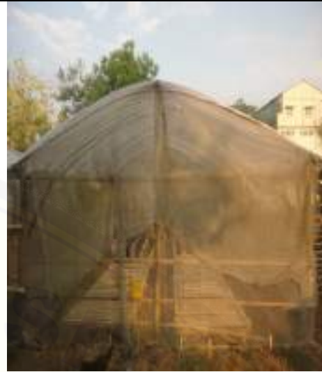
Kondisi luar greenhouse di Patrang
