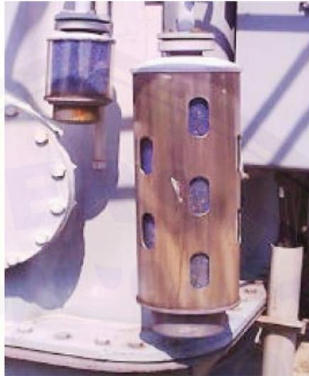
Gambar 2.7 Tempat Minyak Isolasi Pada Trafo
