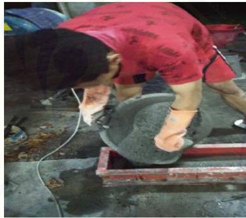
j). Peletakan Campuran ke Bekisting
