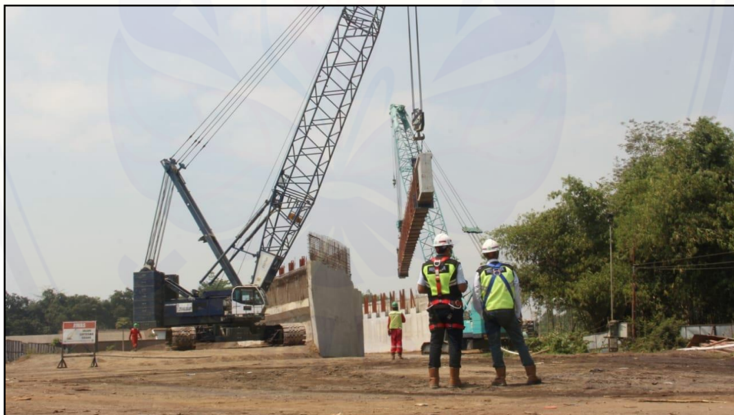
Gambar 4. Proses pengangkatan girder pertama (Sumber : Dokumentasi PT. Waskita Karya)
