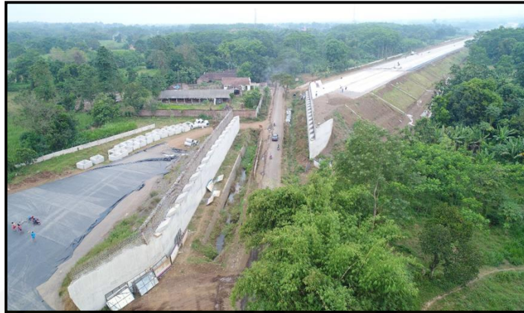
Gambar 3.2 Situasi proyek jembatan underpass Sta. 03+050 (Sumber : www.google.com/maps )
