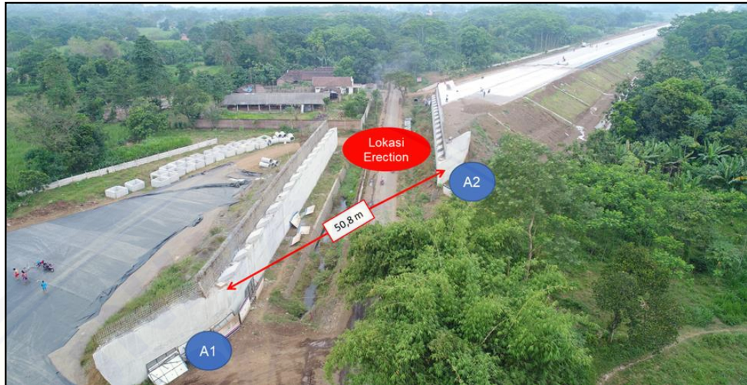
Gambar 1. Lokasi erection girder (Sumber : Dokumentasi PT. Waskita Karya) (Sumber : Dokumentasi PT. Waskita Karya)
