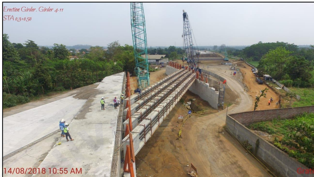
Gambar 5. Peletakan girder ke atas abutment
