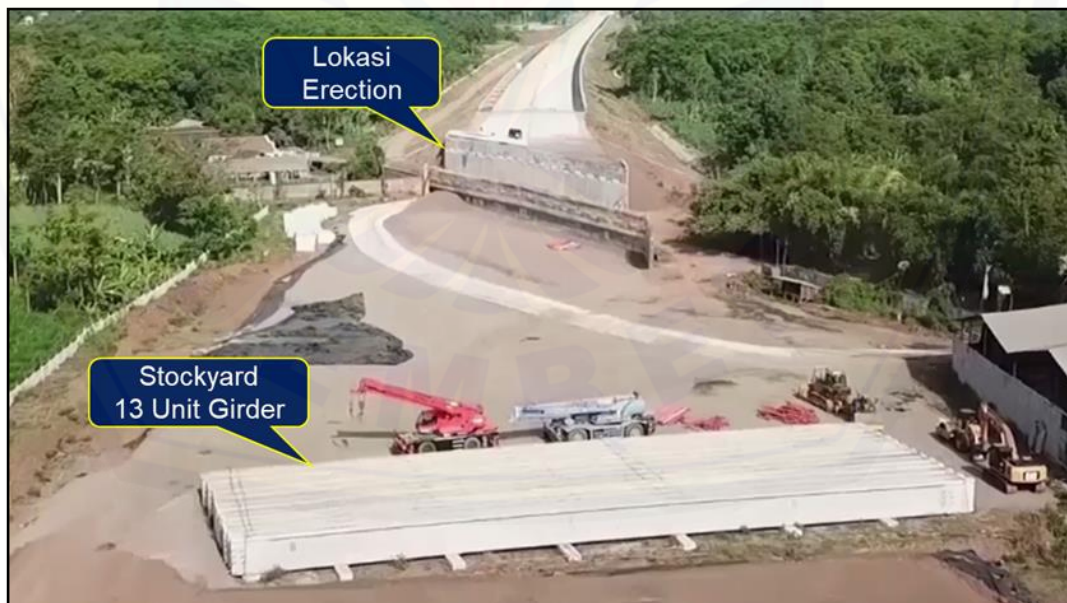
Gambar 2. Posisi stockyard (Sumber : Dokumentasi PT. Waskita Karya) (Sumber : Dokumentasi PT. Waskita Karya)
