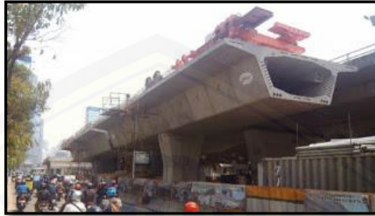
Gambar 2.4 Balok tipe box girder (Sumber : www.sarjanasipil.my.id )
