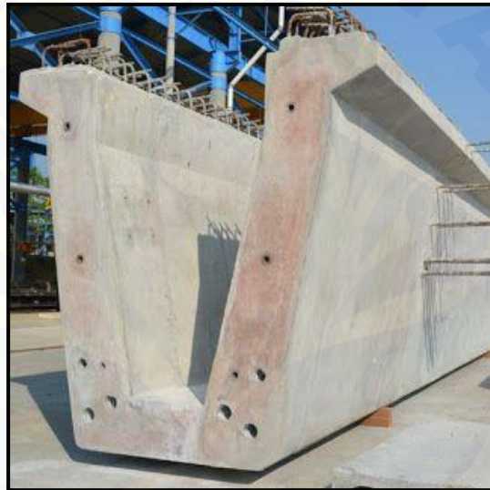
Gambar 2.6 Balok girder tipe PC-U (Sumber : www.pinterest.es )
