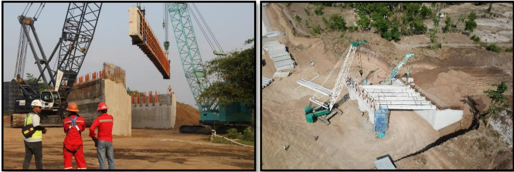
Gambar 2.1 Metode erection menggunakan crawler crane
