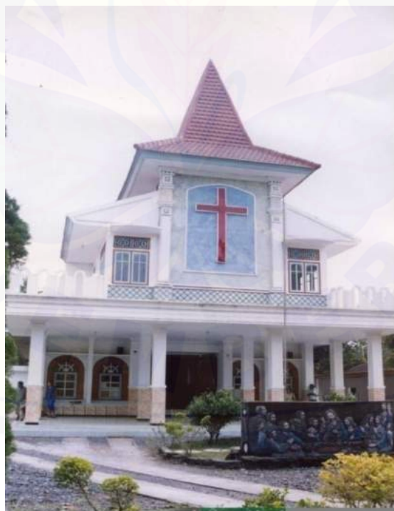
Gambar 6. Gedung Gereja Tahun Pembangunan 2001 Sumber: Dokumentasi GKJW Rejoagung
