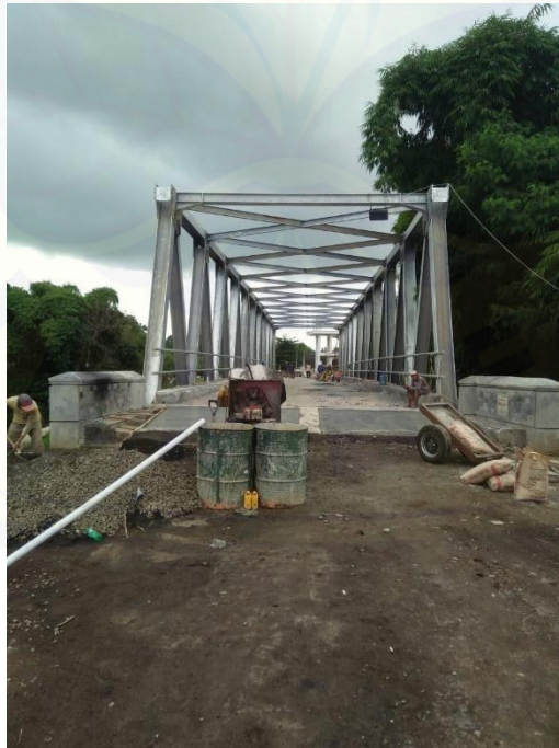
Tampak Jembatan dari Arah Balung ke Ambulu
