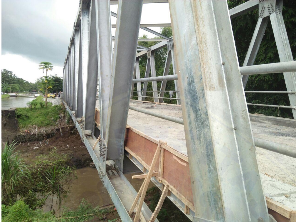
Tampak Jembatan dari Arah Samping
