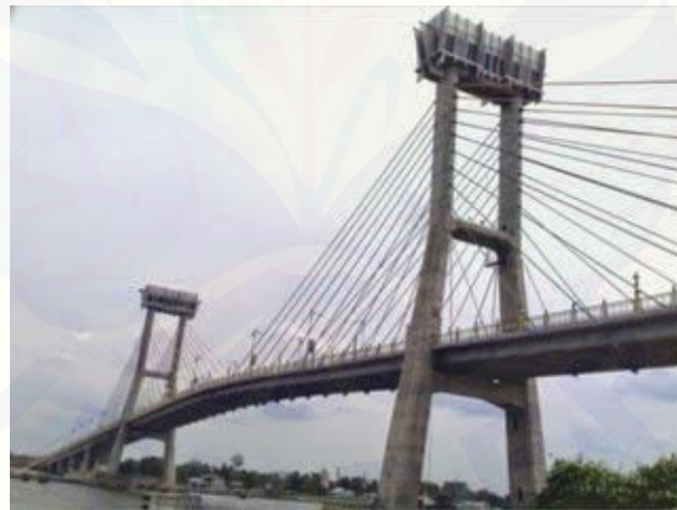
Gambar 2.1. Jembatan Nasional Suromadu dengan bahan kabel penahan dengan elastisitas besar.
