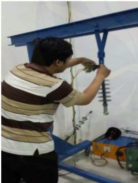
Pemasangan Isolator Polimer
