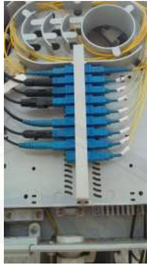
Gambar 2.6 ODP PT Telkom Indonesia
