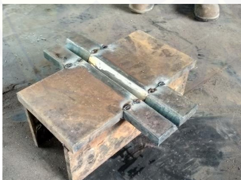
Gambar C.1.5 Persiapan selesai, siap untuk di las
