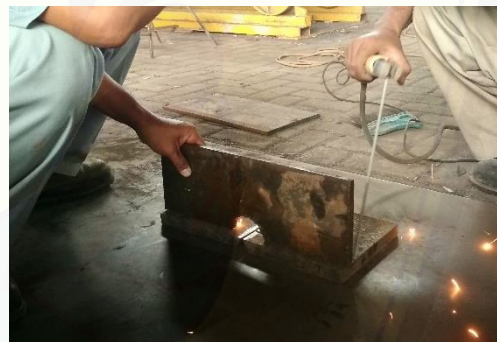
Gambar C.1.4 pemasangan dudukan spesimen las
