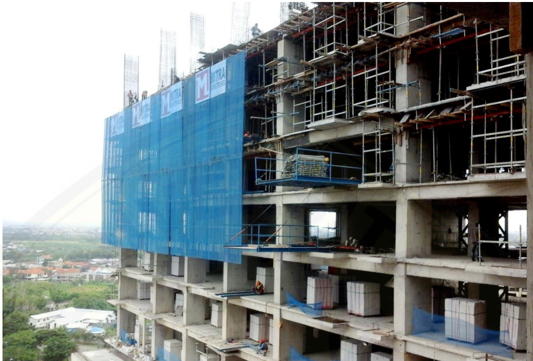
Tampak Samping Proyek
