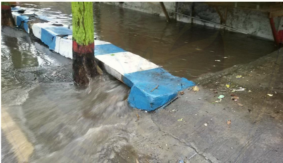
Gambar 3.5 Air Keluar Dari Saluran Ke Jalan (Sumber : BPBD tahun 2017)
