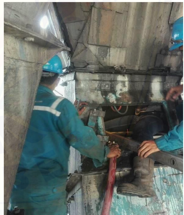
Gambar 12. Proses memasuki man hole
