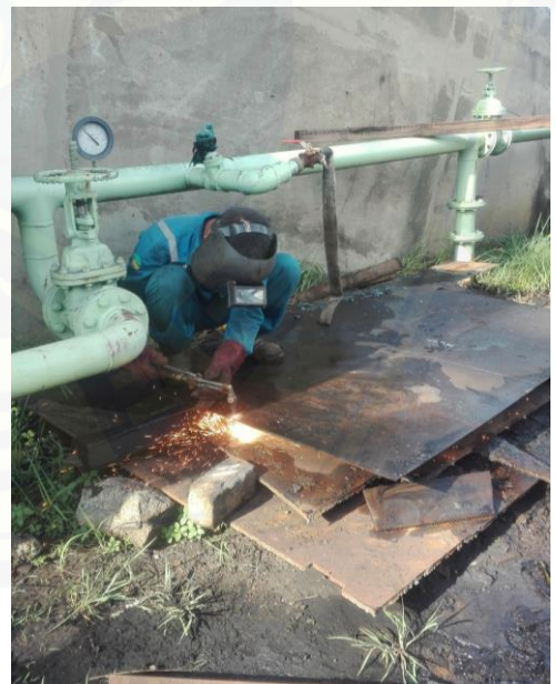
Gambar 4. Pemotongan plat
