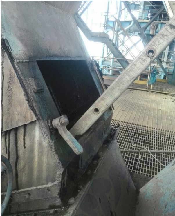
Gambar 13. Memasukkan tangga ke man hole
