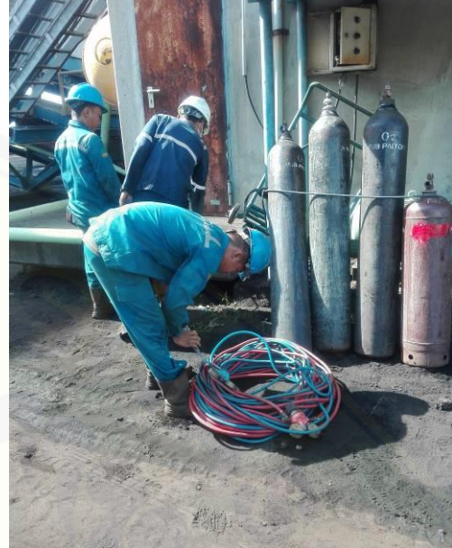
Gambar 2. Persiapan pemotongan plat
