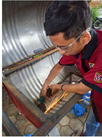
Gambar C.18 Proses Pembuatan Lubang Pengapian
