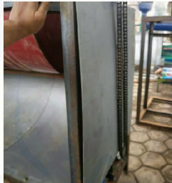
Gambar C.31 Proses Pemasangan Penutup Samping
