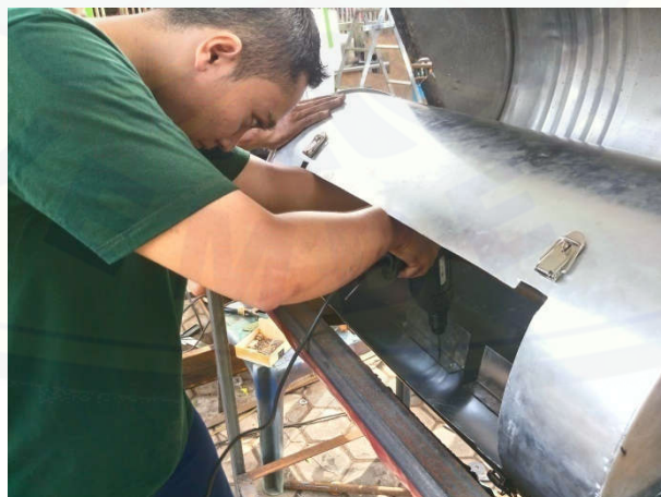
Gambar C.26 Proses Pemasangan Pengaduk didalam Tabung
