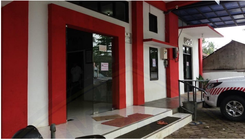
Gambar 5. Pintu masuk di Puskesmas Jelbuk
