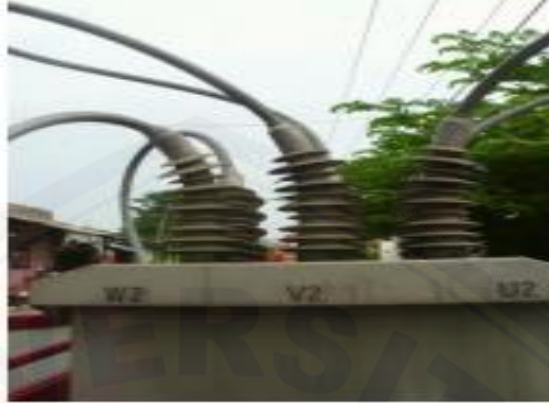
Gambar 2.4 Contoh penempatan bushing recloser sisi beban
