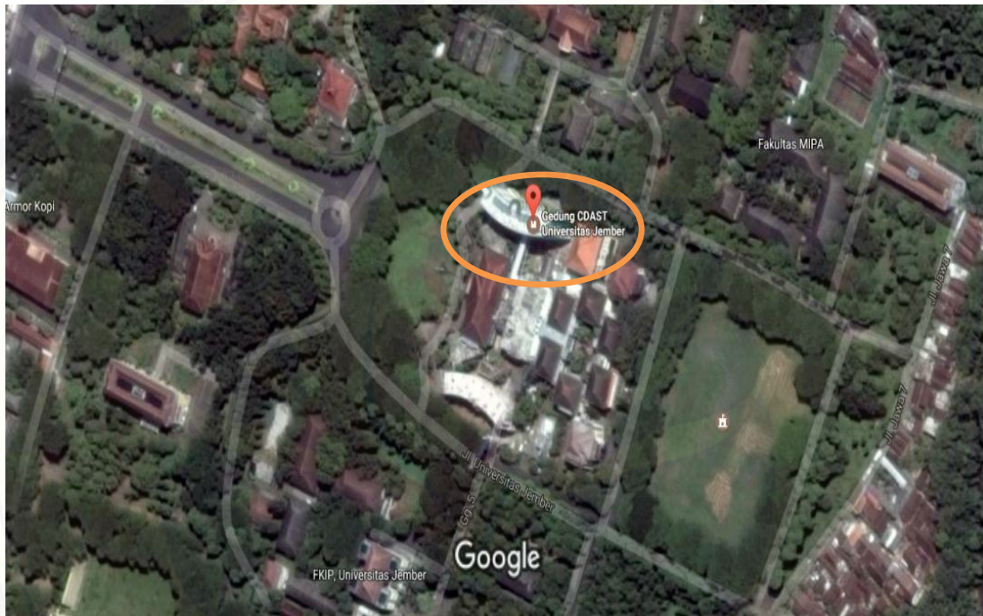
Gambar 3.1 Lokasi Bangunan Gedung 8 Lantai
