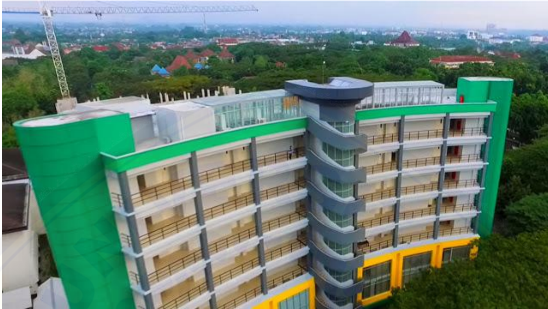
Gambar 3.2 Bangunan Gedung 8 Lantai
