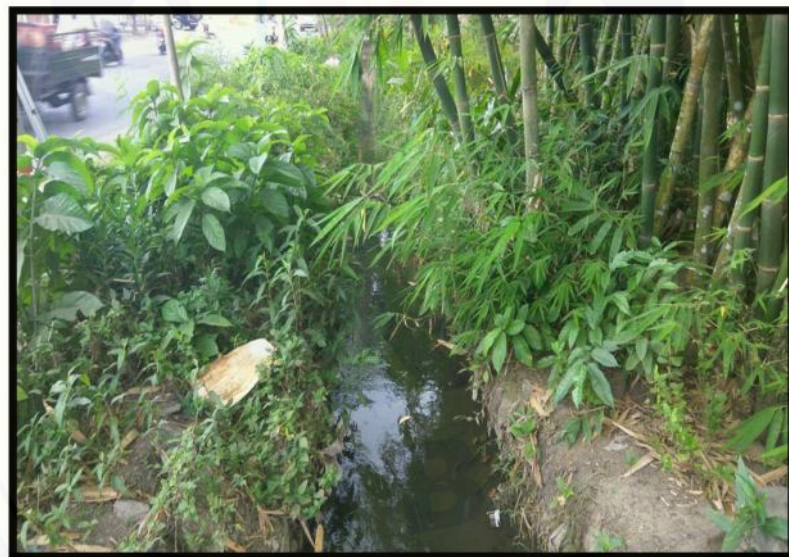
Gambar 5. Kondisi eksisting saluran drainase
