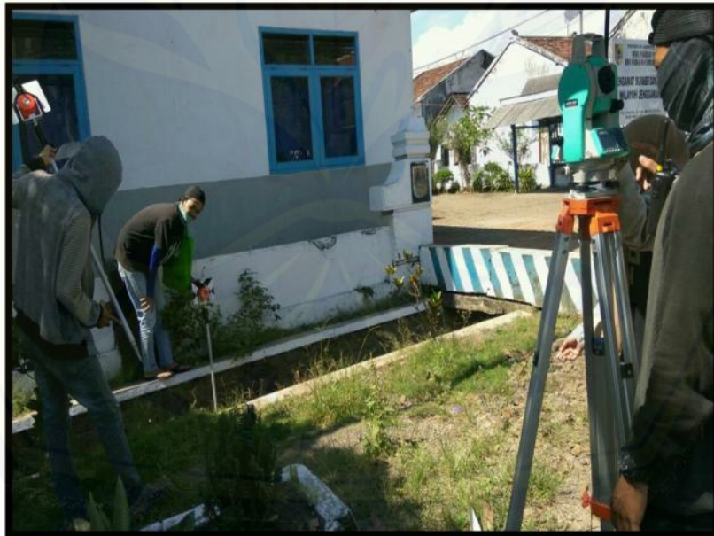
Gambar 11. Penembakan titik dimensi saluran drainase
