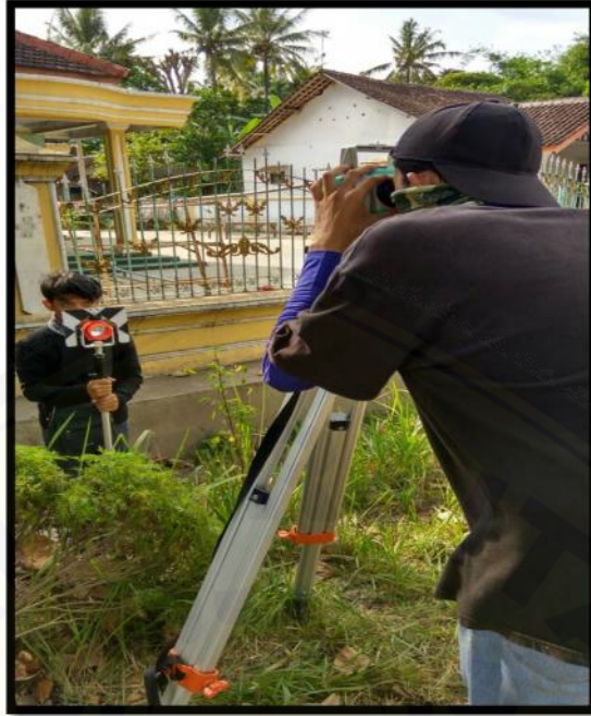
Gambar 10. Penembakan titik dimensi saluran drainase
