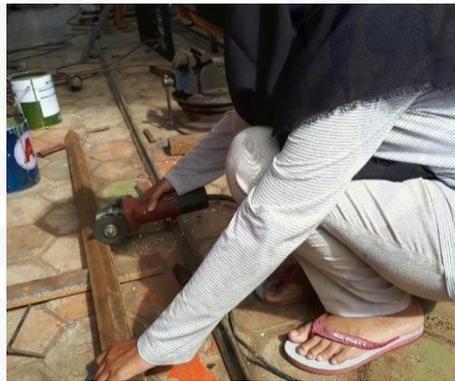
Gambar 3.2 Proses Pemotongan Besi Profil L
