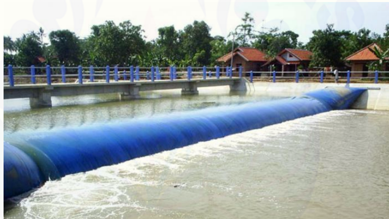
Gambar 2.7 Bendung Gerak dengan Pintu Karet
