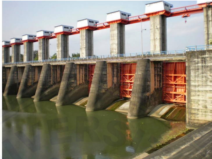
Gambar 2.6 Bendung Gerak dengan Pintu Air
