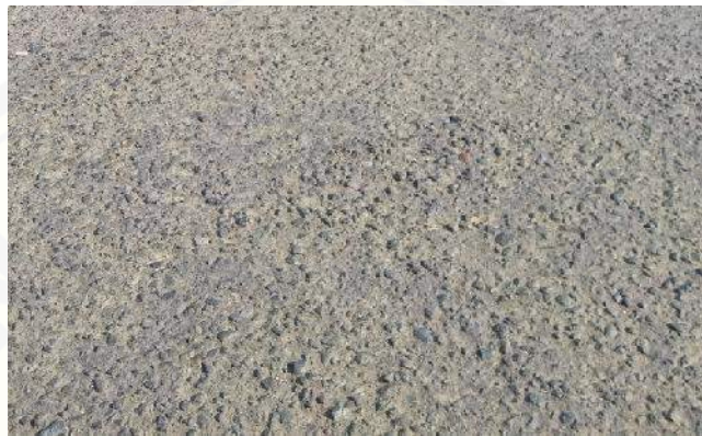
Gambar 2.10 Kerusakan pelepasan butiran (Sumber : Kurnia,2016)
