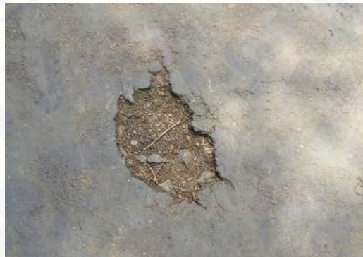
Gambar 2.7 Kerusakan lubang
