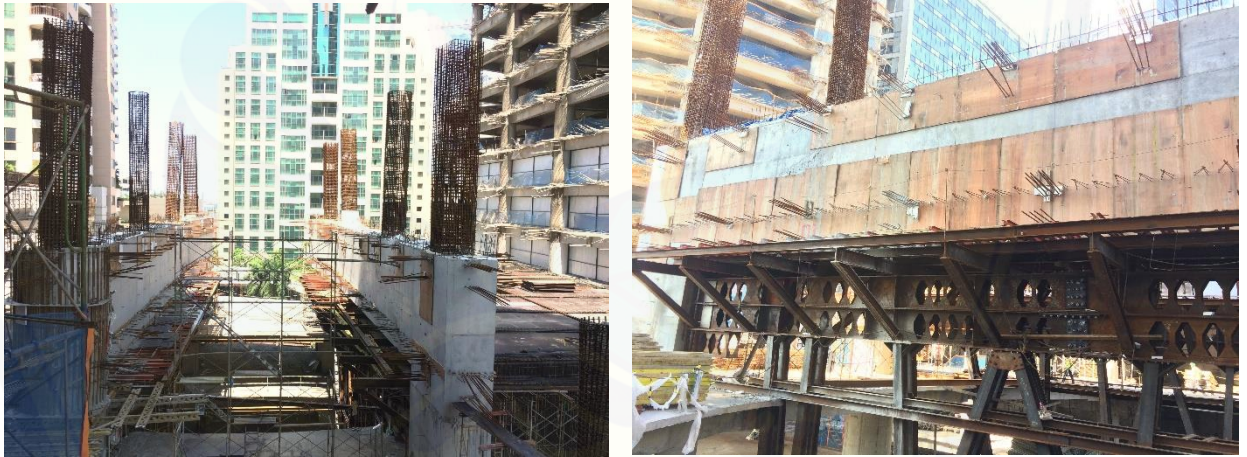
Gambar 2.2 Transfer Beam Column yang ada di Proyek Tunjungan Plaza 6 Surabaya
