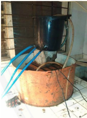
Bak penampung air
