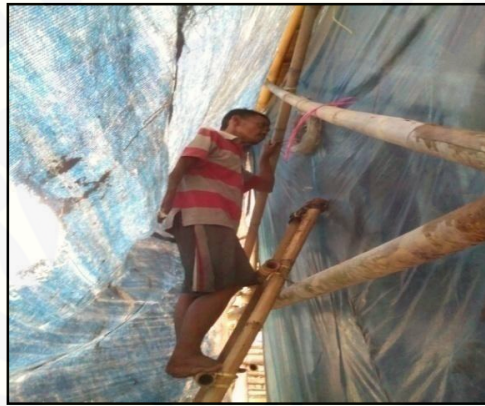
Gambar 4.5 Pembukaan Ventilasi Udara
