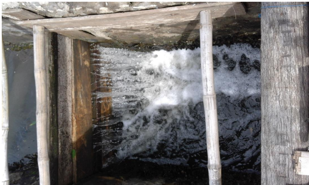
Gambar 8. Drainase pada tambak tradisional
